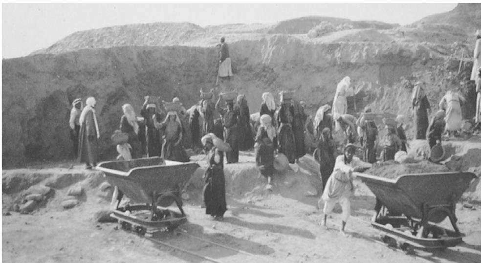
Fig. 3.13 - La stazione di partenza della ferrovia installata da J. Garstang per la rimozione della terra di risulta (da Garstang - Garstang 1948, tav. II,b).
